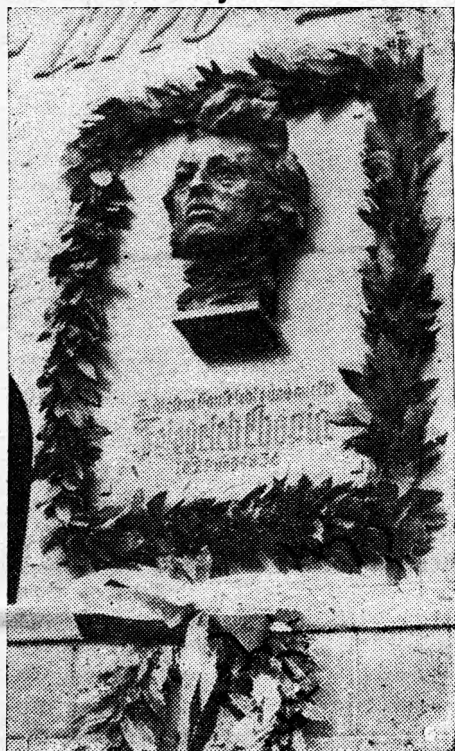
Tablica pamiątkowa na frontowej ścianie hotelu w Dreźnie, w którym mieszkał Chopin.
