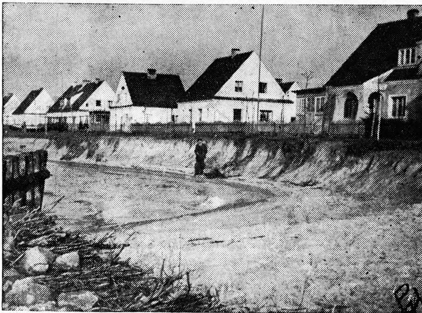
Po ostatniej burzy półwysep helński w okolicach Matej Plaży koło Helu przedstawia widok ogromnego zniszczenia. Woda podmywając piasek grozi splotaniem wybrzeża, na którym ciągnie się Aleja Nadmorska. Na zdjęciu widok na zniszczony odcinek Matej Plaży pod nową kolonją rybacką, na pierwszym planie wielka wyrwa i zagrożone runięciem domy.
