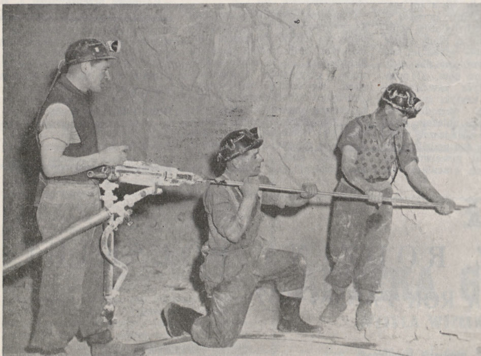
W kopalni Whitehaven (Mine of Marchon Products Ltd.), znajdującej się w pobliżu Calder Hall, wiercenia odbywają się przy pomocy energii pochodzącej z nowej elektrosiłowni atomowej.
