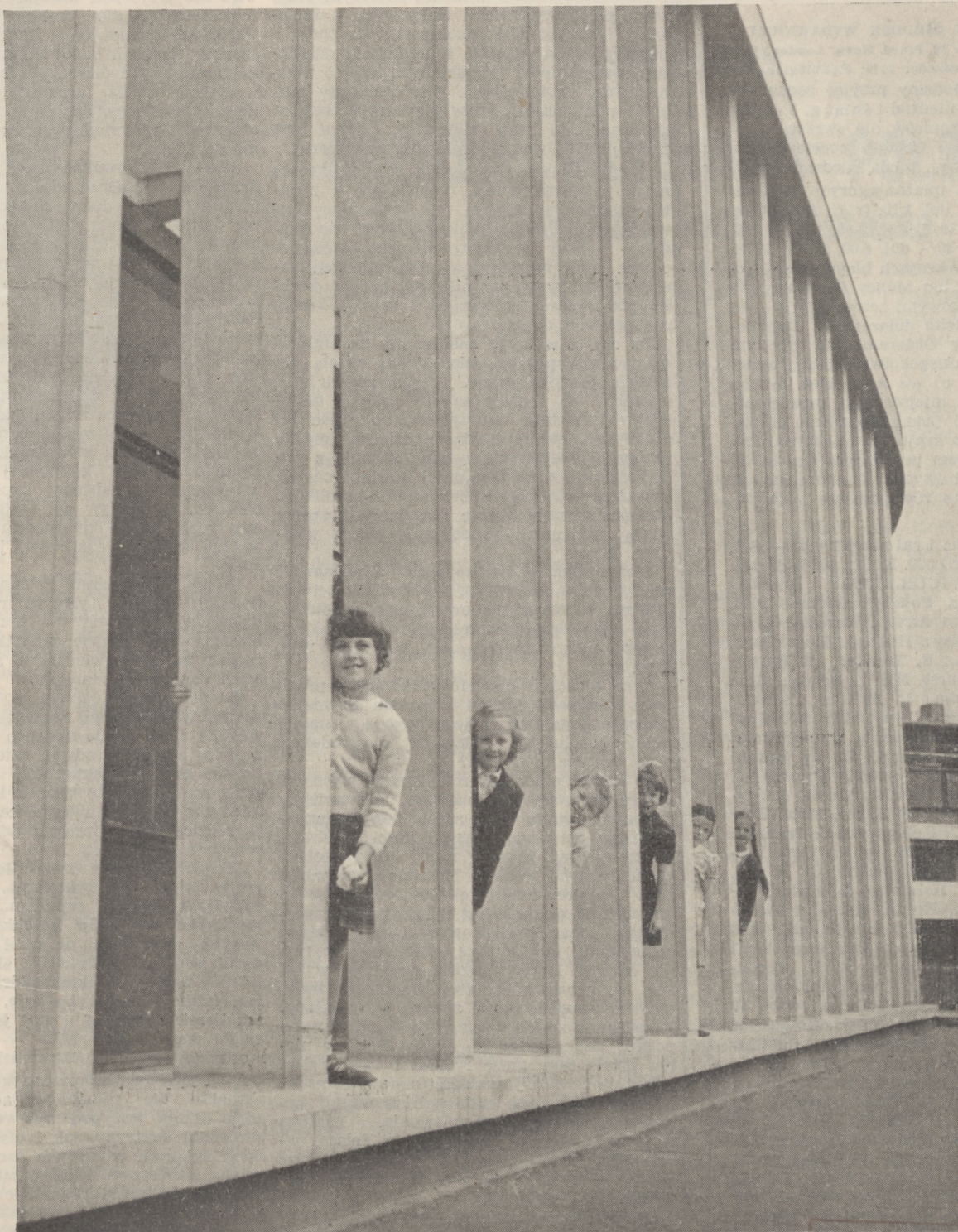
Nowoczesna kolumnada zastosowana w szkole przy Bishop's Road w Londynie, sprawia że klasy mają dużo światła wyeliminowanego z blasku, który mogłyby razić oczy uczniów. Kolumny służą przy tym dzieciom do zabawy w chowanego
