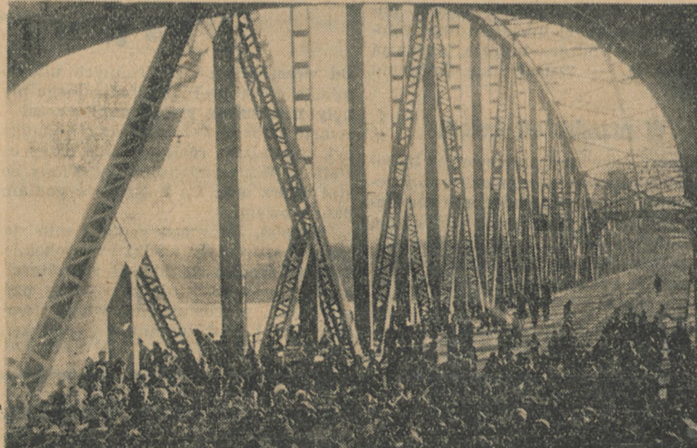
W chwilę po otwarciu mostu.
