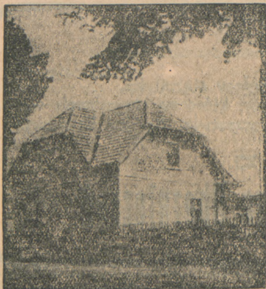
Nowa budowa naszego członka właśc. domu p. Piotra Kamińskiego, Tczew, Wybickiego 27, pożycz. zł 8.000,—
