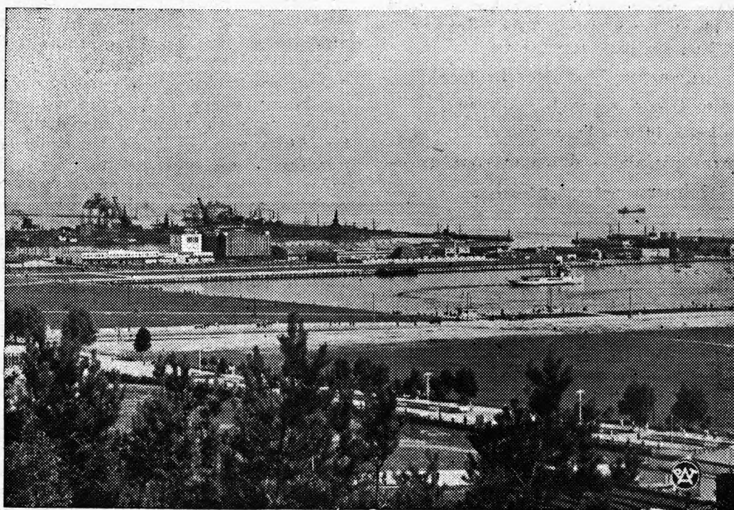
WIDOK PORTU GDYNSKIEGO Z KAMIENNEJ GÓRY.
