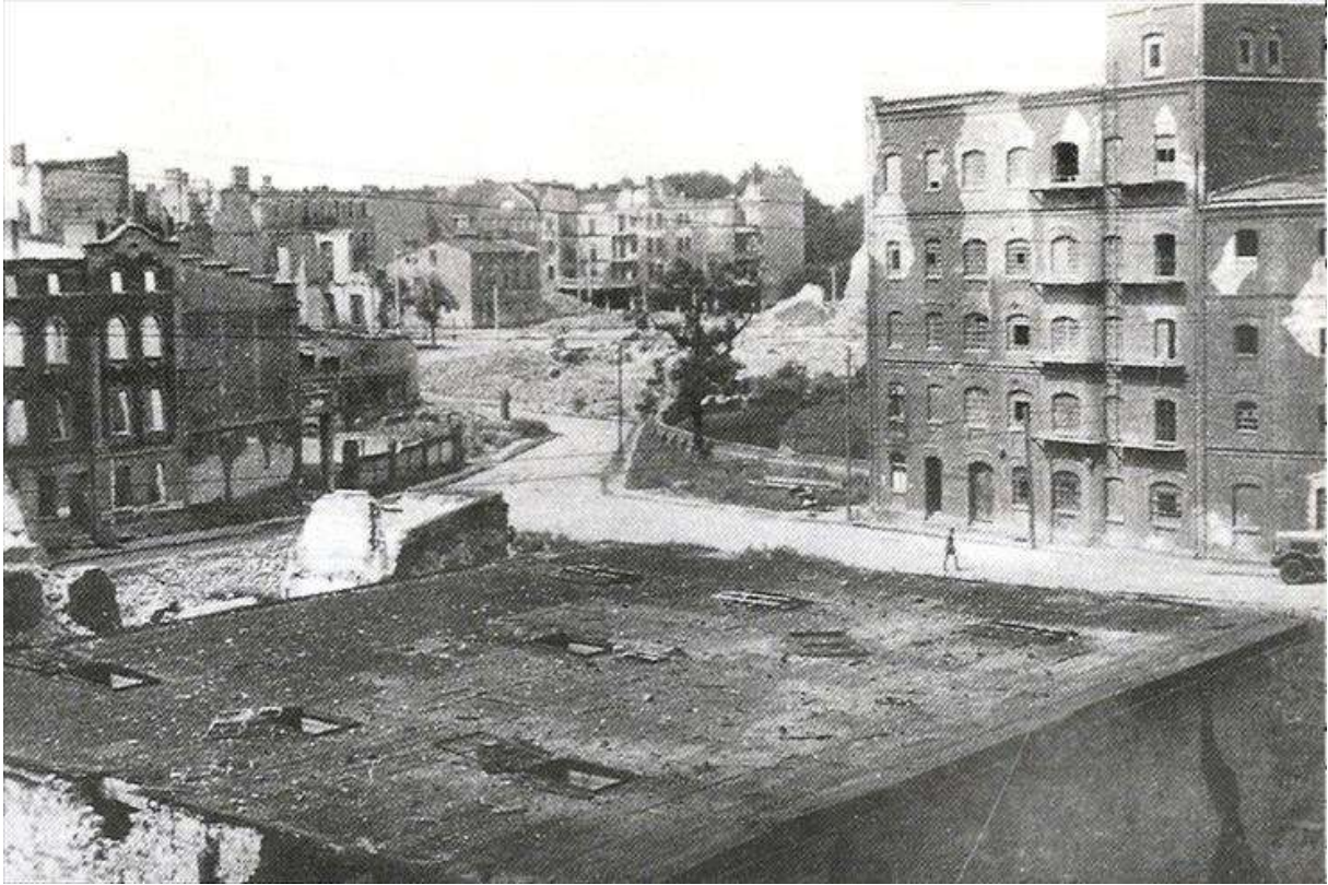
Zniszczenia wojenne na Placu 23 Stycznia i ul. Młyńskiej. Fot. T. Walesa.
