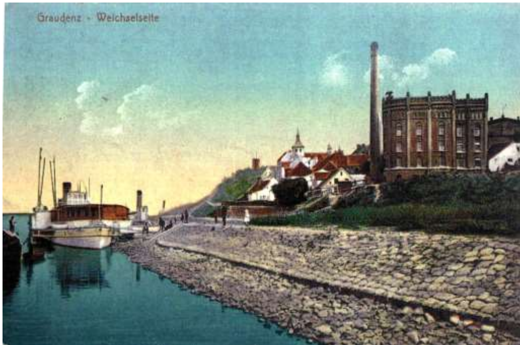
Rozbudowane nabrzeże dla statków w Grudziądzu. Zbiory Zbigniewa Zawadzkiego
