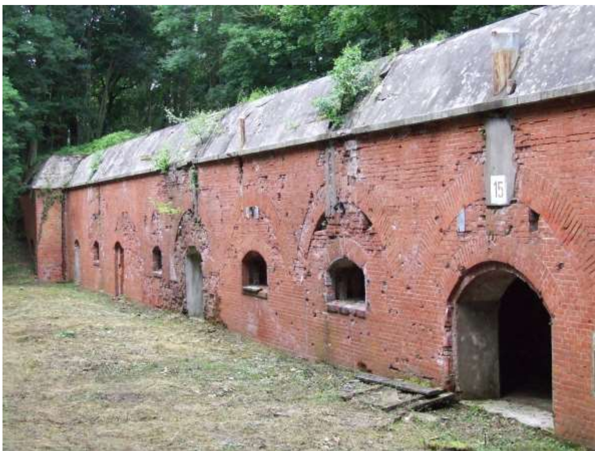
Schron baterii pancernej na Wielkiej Księżej Górze
