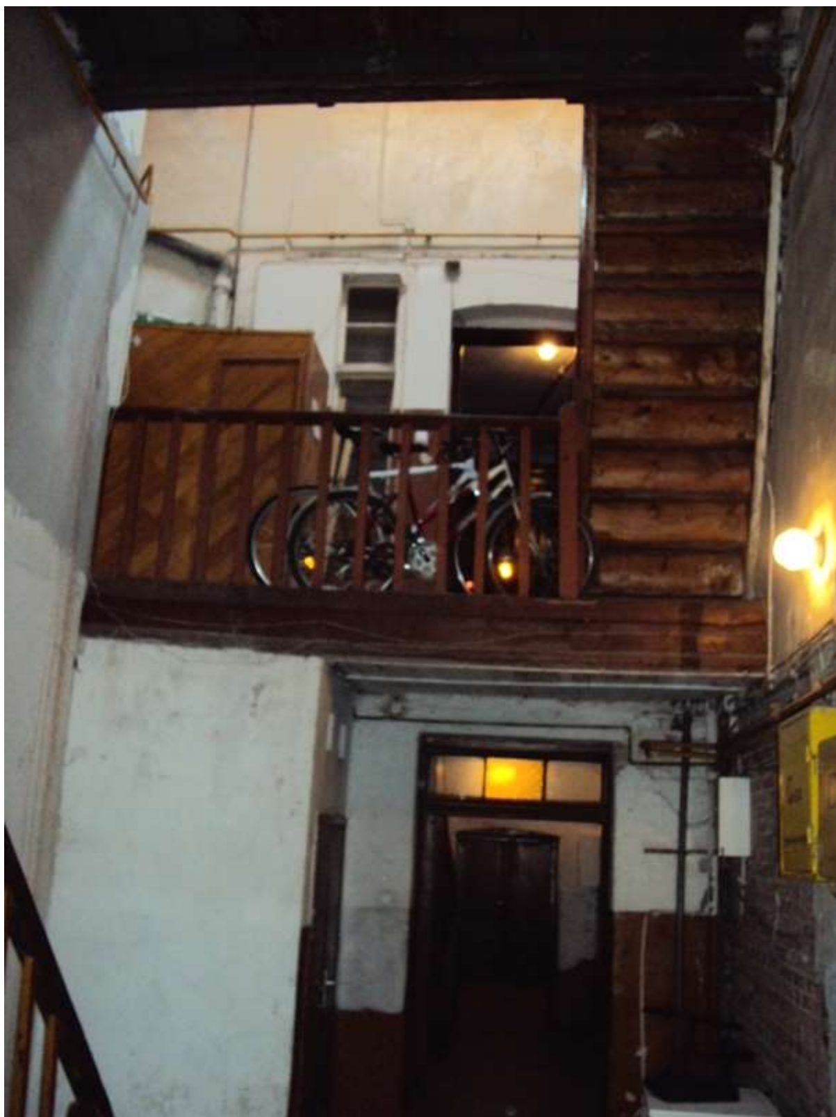
10. Sień kamienicy przy ul. Starej 23. Strona wschodnia. Stan z 2.10.2017 r.
