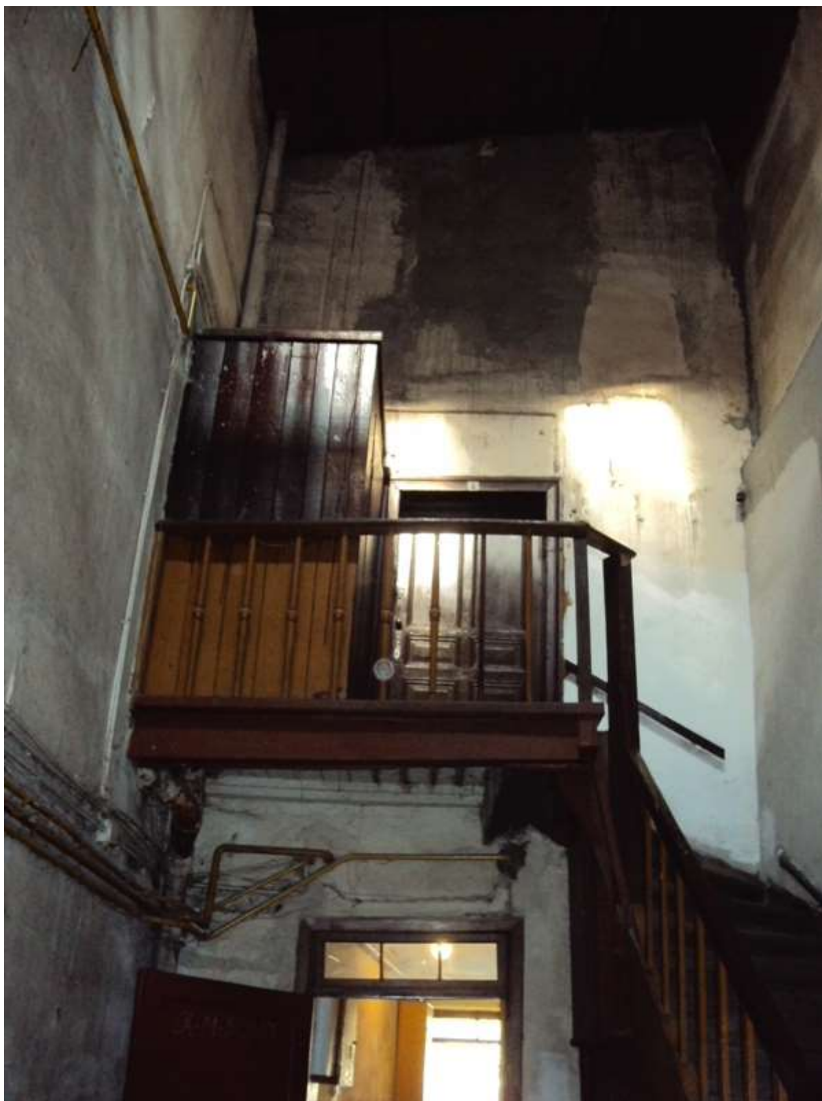
9. Sień kamienicy przy ul. Starej 23. Strona zachodnia. Stan z 2.10.2017 r.
