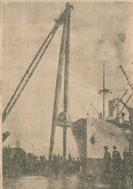
Turbiny dla elektrowni „Gródek” orzywiezione do Gdyni z Anglii na statku „Polbrytu” — „Lublin”. Jak widać na zdjęciu, turbiny wydławadawce dźwig piywający.
