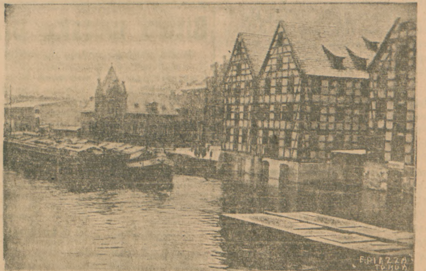
Piwnice zakładów przemysłowych L. Urbanowskiego w Bydgoszczy przy Rybim Rynku pod wodą
