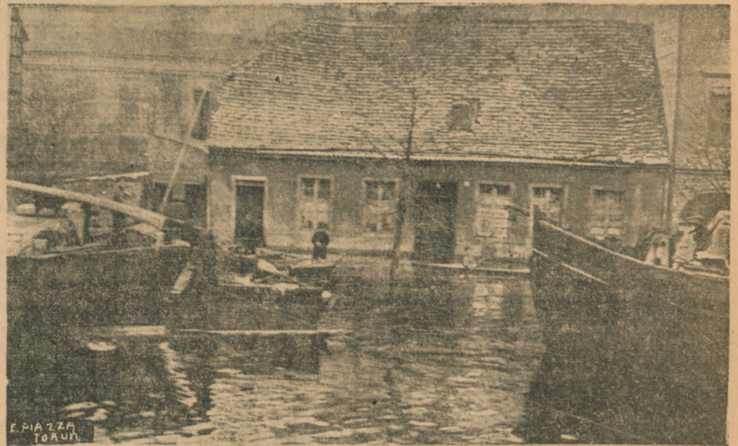
Stary domek przy ul. Hermana Frankego w Bydgoszczy pod wodą. Dojazd do tegoż domu odbywa się łódkami
