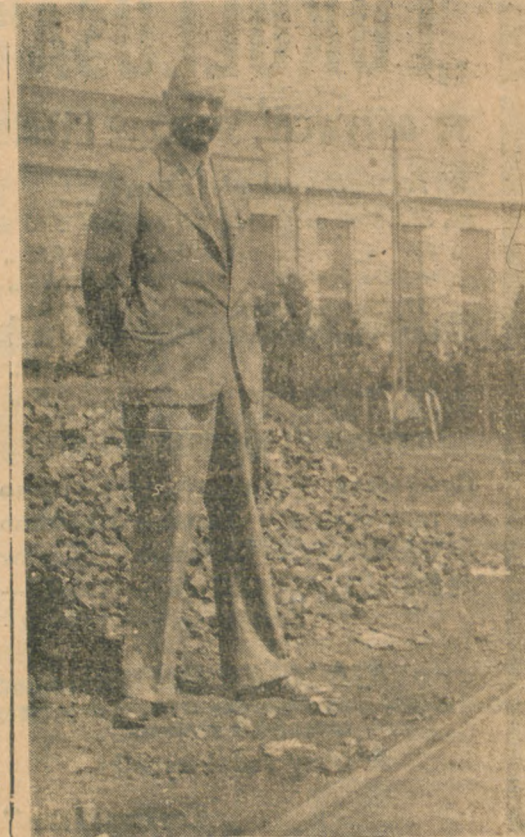
Dyrektor Gazowni, Elektrowni i Tramw. jów Miejskich p. inż. Tadeusz Jeleński (na tle podstacji transformatorowej „Gródek”).
