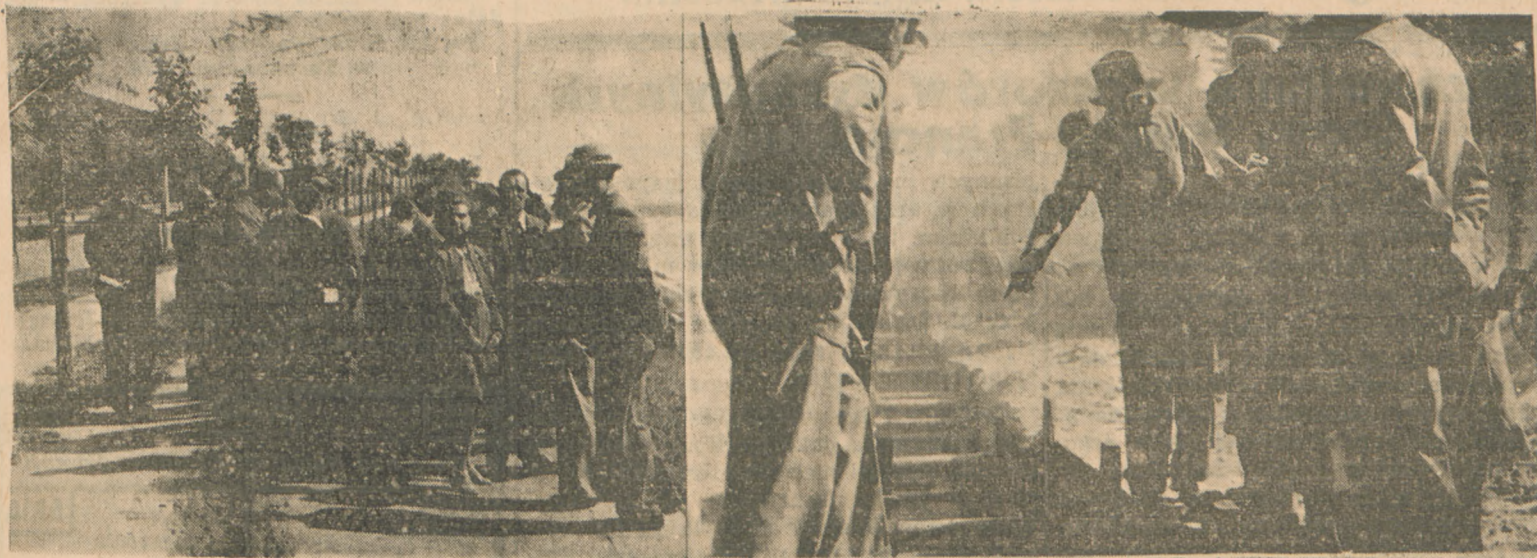
1) Grupa dziennikarzy warszawskich w Toruniu na ul. Traugutta, zwiedza roboty, wykonywane przy umacnianiu stoków nadwiślańskich. 2) Budowa magistratu wodociągowej w Toruniu na przestrzeni 5-ciu km od portu drzewnego do miasta.
