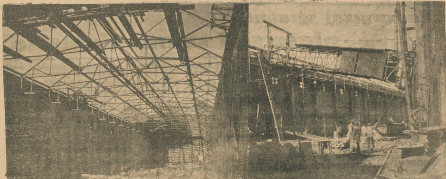
Budowa magazynu mogącego pomieścić 90.000 worków, obok budowa mostu-łaśmy.
