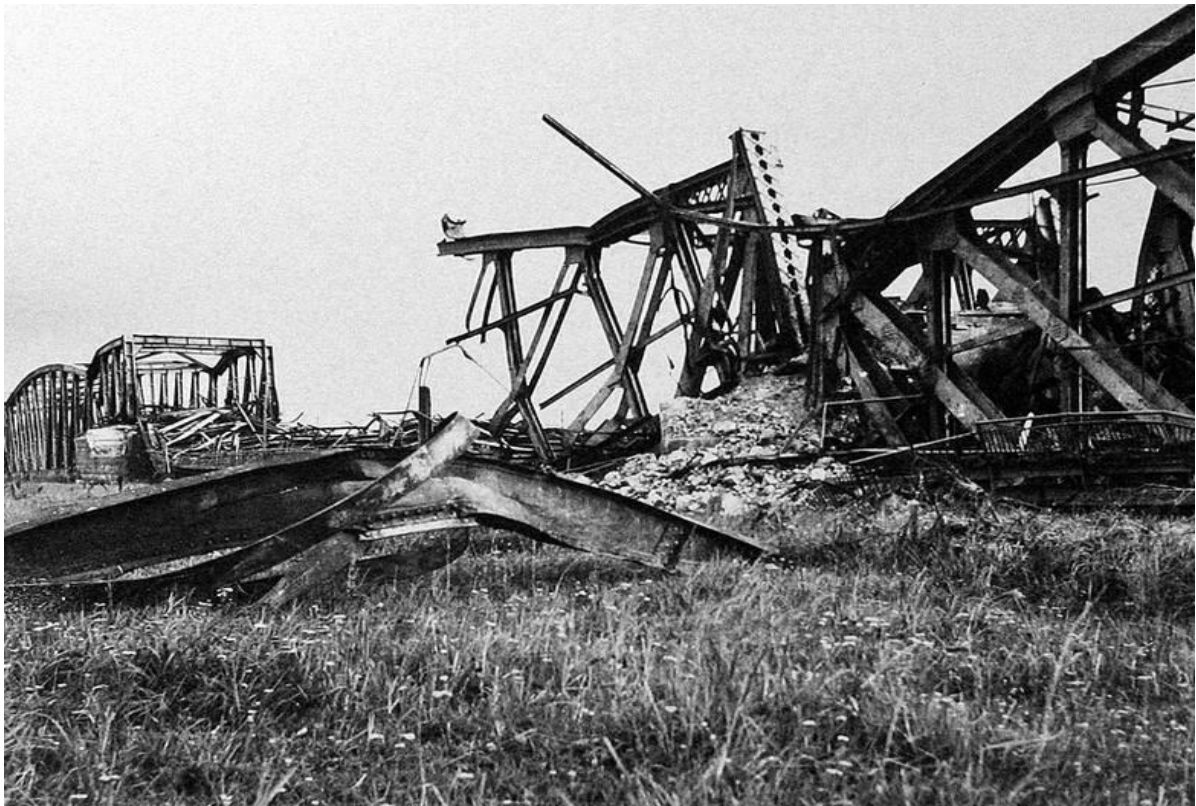
Zniszczony gruziędzki most przez Wisłę
