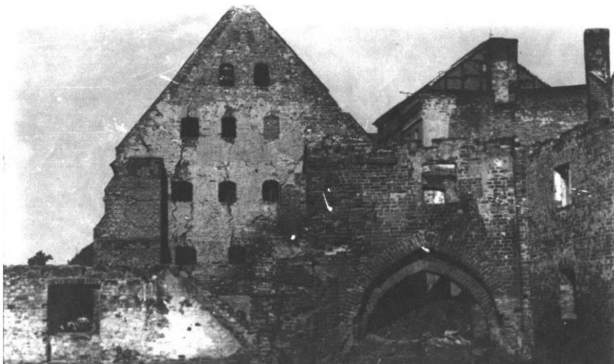
Zniszczona Brama Wodna
