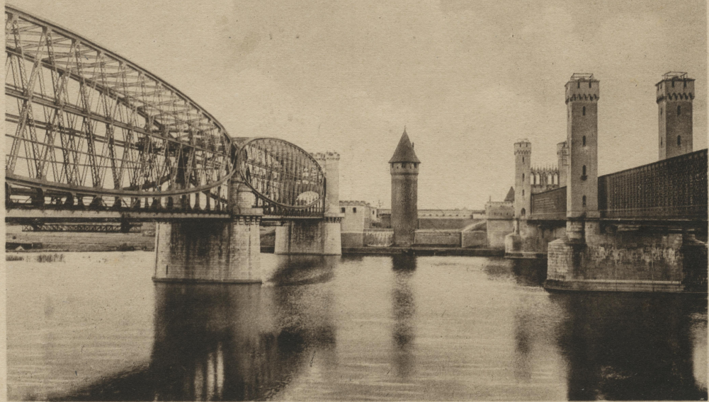
Marienburg, Westpr. - Eisenbahnbrücken u. Buttermilchturm
