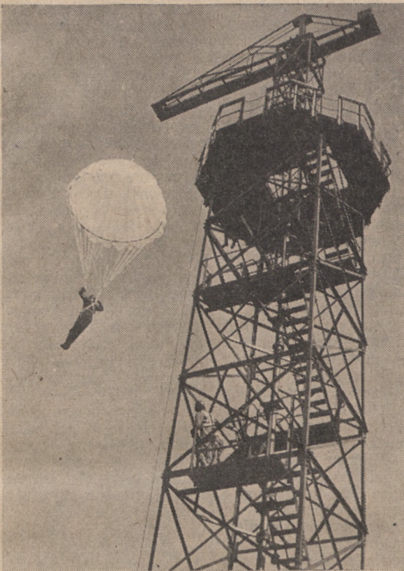
W czasie ćwiczeń wstępnych pokazano skoki z specjalnej wieży. Wieża ta została zbudowana całkowicie według wzorów polskich i spotkała się ze słowami uznania ze strony brytyjskich wojskowych.
