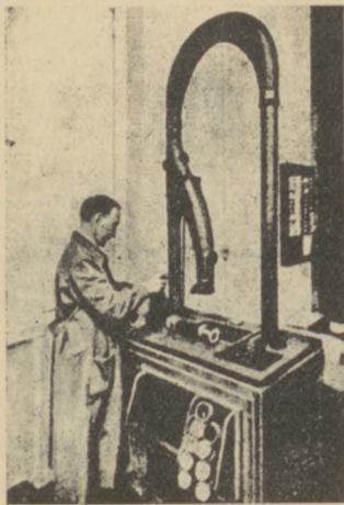
Ryc. 183. Poczta pneumatyczna w P.K.O. w Warszawie.
