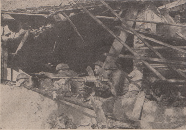
Stanowisko ogniowe w zrujnowanym domu
