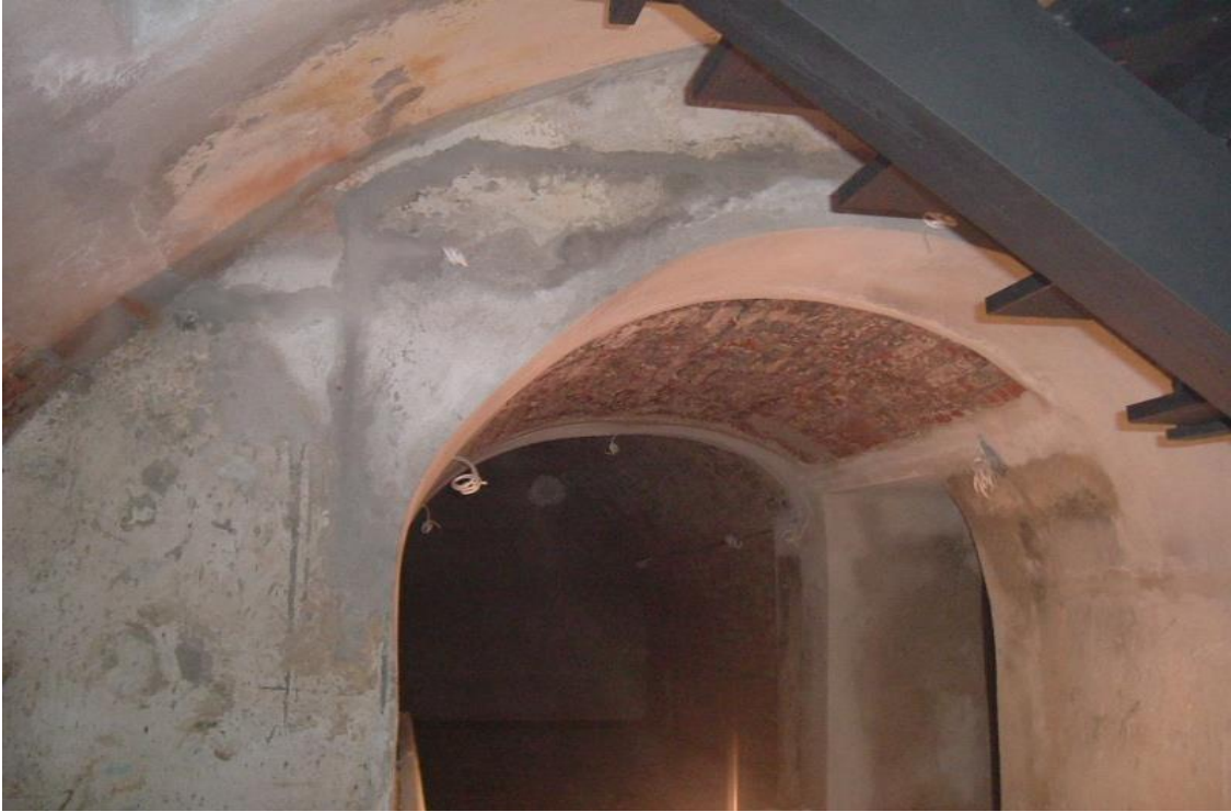
Ryc. 4. Furta średniowieczna w piwnicy kamienicy przy ul. Mickiewicza 1. Widok od strony wschodniej. Stan z ok. 2010 r. Fot. M. Szajerka.
