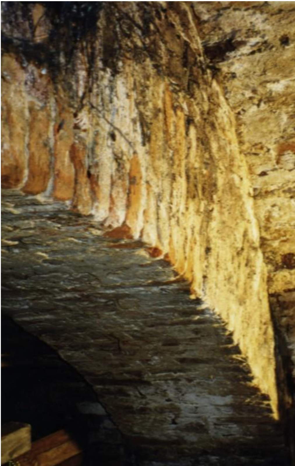
Ryc. 6. Most Bramy Bocznej. Fot. M. Szajerka.
