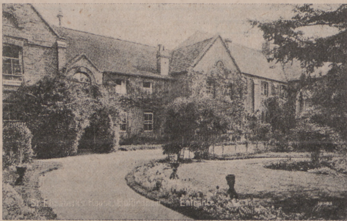
Front głównego budynku zakładu w Lower Bullingham, Hereford.
