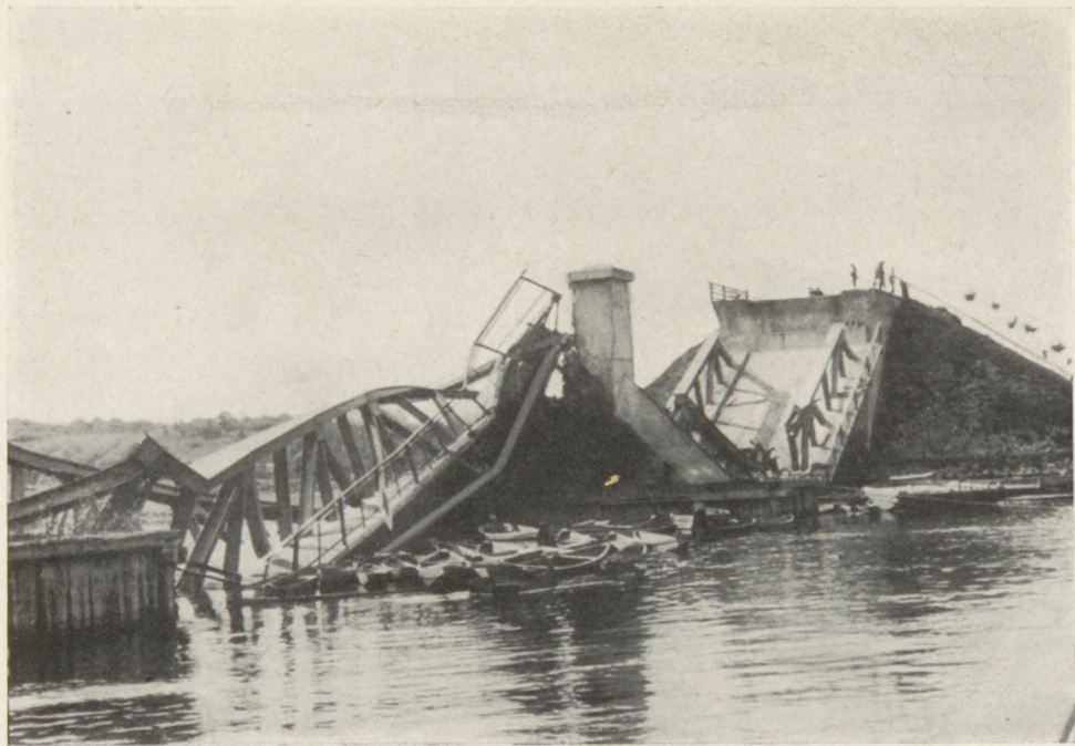
Ponte saltato in aria nelle vicinanze di Pulstuk.
