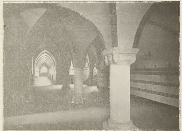
Wandelhalle mit Korridor
