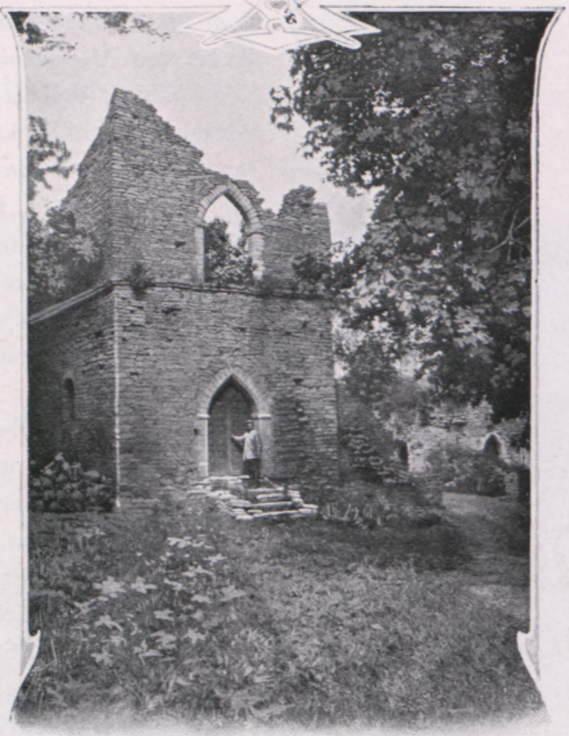
Faehna — Ruine des alten Wohnhauses.
