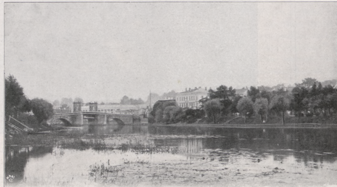
Blick auf die Steinbrücke mit den Embachanlagen.
