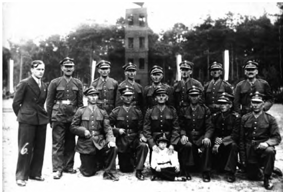
Zakładowa straż pożarna w latach 50. XX wieku
