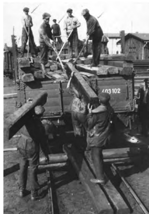
Ręczny załadunek podkładów z wykorzystaniem haków
