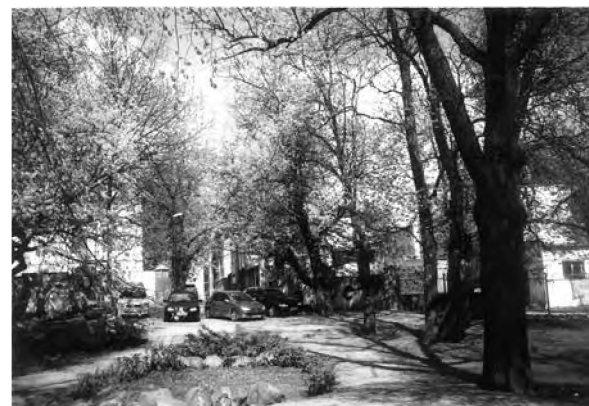
Komora śluzy pierwszej na starym kanale przy ulicy A. Grottgera. Obecnie w tym miejscu znajduje się przystanek Garbary. Po prawej dom mieszkalny „śluzowego”, za nim widoczne dęby opisane w tekście (fot. ze zbiorów Henryka Skrzypińskiego)
