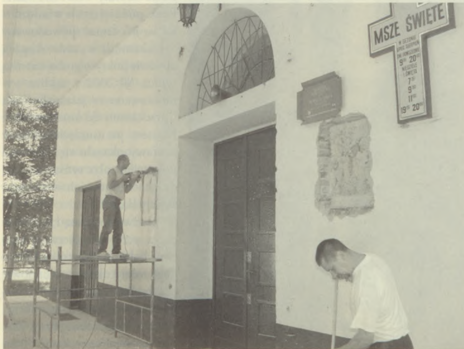
Prace podczas odkuwania płyt ze ściany kościoła p.w. Bożego Ciała w Helu, 2002 r.,
