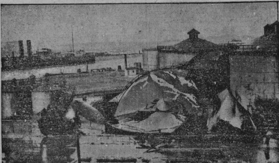
W Zeebrügge na skutek mrozów metalowy zbiornik melasy tak się skurczył, że ściany jego popękały, a melasa wypłynęła zamieniając się w bryły zlodowaciała.
