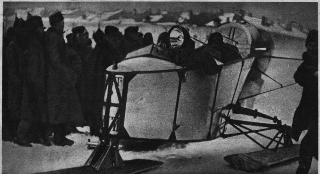
Najnowszy typ sanek motorowych, poruszanych zapomocą śmigła, które osiągają szybkość ponad sto kilometrów na godzinę. Photo Atlantic-Co
