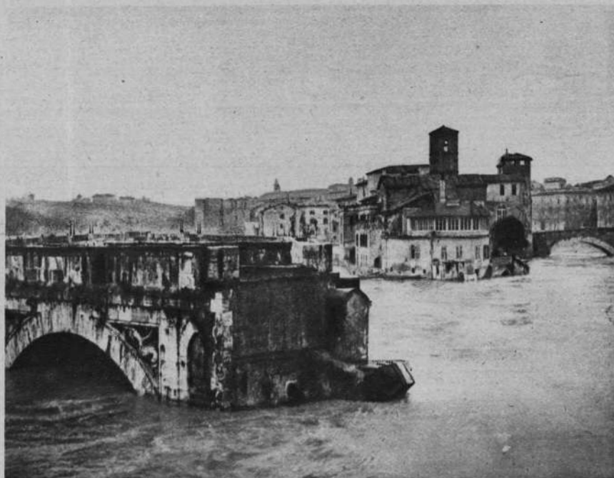
We Włoszech nastąpił gwałtowny wylew Tybru, wywołany nieustannymi deszczami. Zdjęcie wyspy Św. Bartłomieja, której grozi zupełny zalew. Vita-Foto-Press
