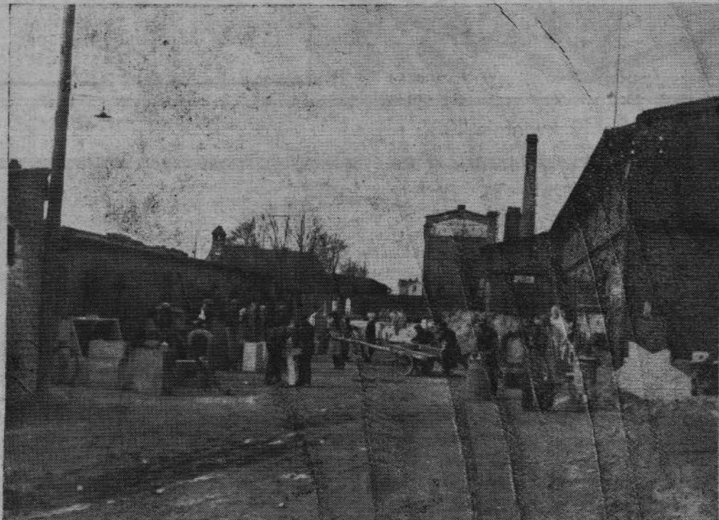
Widok na fabrykę nagrobków p. J. Kamińskiego.
