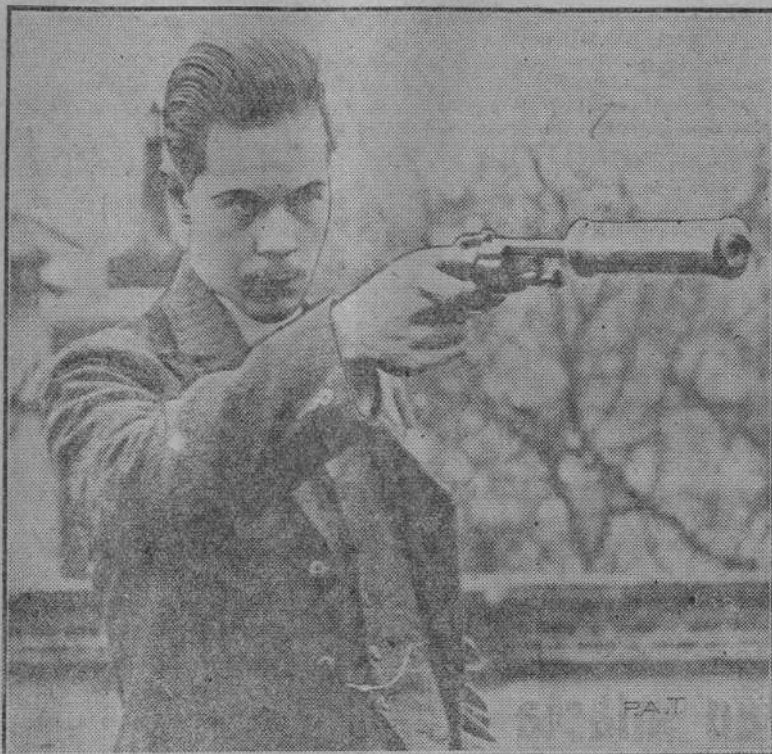
Młodemu, 22-letniemu inżynierowi R. Chapmanowi z Caterham Valley udało się skonstruować tłumik do rewolweru o niezwyklej skuteczności. Przy zastosowaniu tego tłumika nie słyszy się strzałów już z odległości kilku kroków. Poza to tłumik pochłania dym z wybuchającego pocisku. Zdjęcie nasze przedstawia wynalazcę z rewolwerem zaopatrzonym w tłumik.
