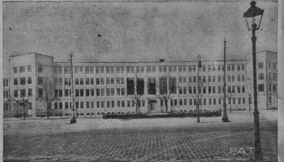
Na posiedzeniu Rady Ministrów zapadła ostateczna uchwała przeniesienia siedziby dyrekcji kolejowej z Gdańska do Torunia. Ilustracja nasza przedstawia gmach, do którego przeniesione będą biura dyrekcji.
