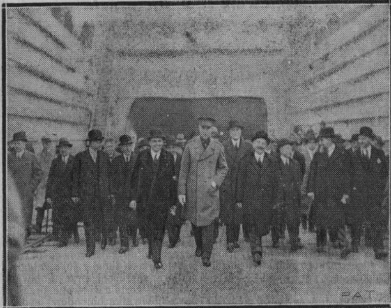
Przed kilku dniami odbyło się w obecności króla Belgów uroczyste otwarcie dwóch tuneli biegnących głęboko pod Skaldą i łączących Antwepę z Tete Flandre. — Na zdjęciu naszym widzimy króla oraz jego otoczenie wychodzących z tunelu.
