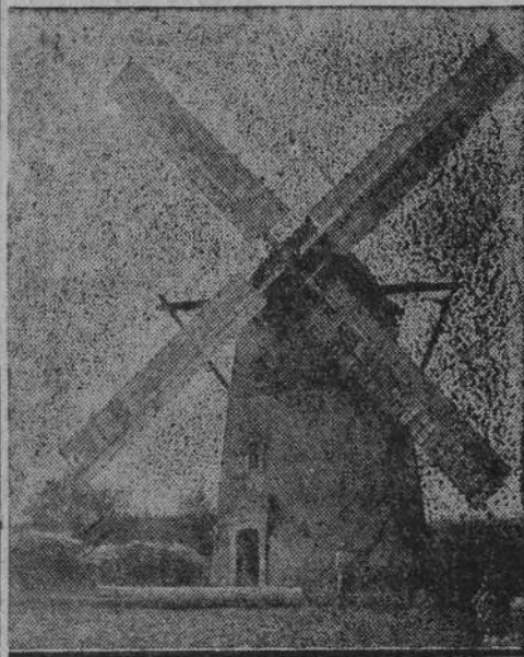
Prawdziwą ozdobą naszych krajobrazów są wiatraki; powoli zupełnie zanikające i ustępujące miejsca młynom wodnym i parowym. Na zdjęciu widzimy wiatrak w Nowem nad Wisłą na Pomorzu, zbudowany z cegły, w typie holenderskim.
