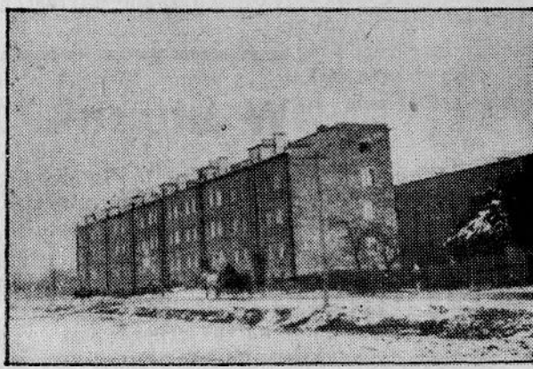
Ulica Hetmańska — budowa bloków robotniczych.
