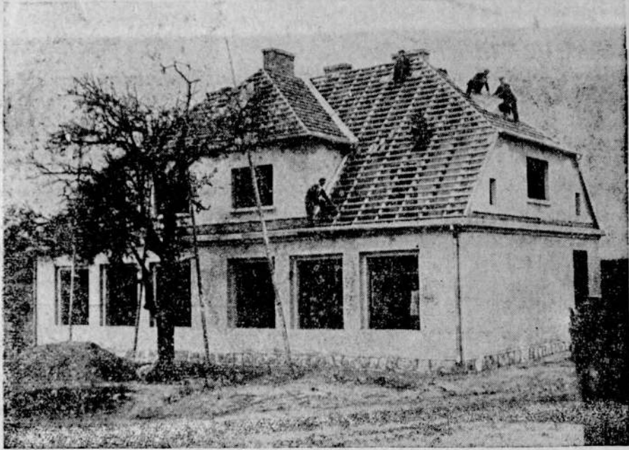
Budynek pod dachem. Publiczna szkoła powszechna w Nielba pow. lubawski, wznoszona z pomocą Towarzystwa.
