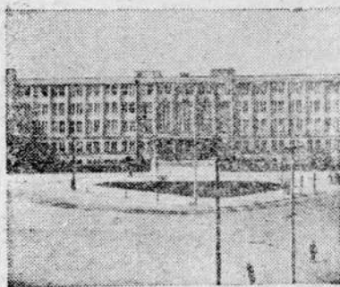
Gmach dyrekcji kolejowej
