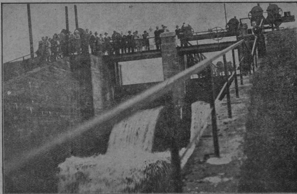
Śluza na Czarnejwodzie, pędzącej turbiny znanych zakładów elektryfikacyjnych w Gródku
