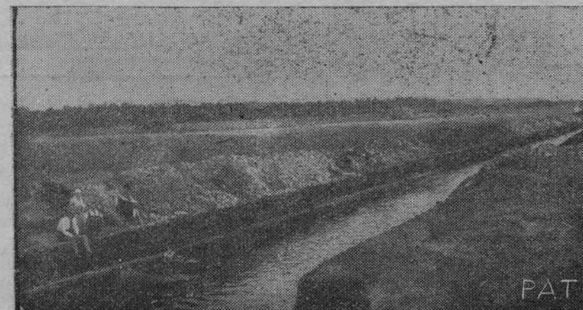
Na zdjęciu widzimy rzekę Wiedźmę i pobliskie łąki, które—przed miesiącem były jeszcze ogromnym bagnem dziś zaś, dzięki pracom meljoracyjnym zostały osuszone.
