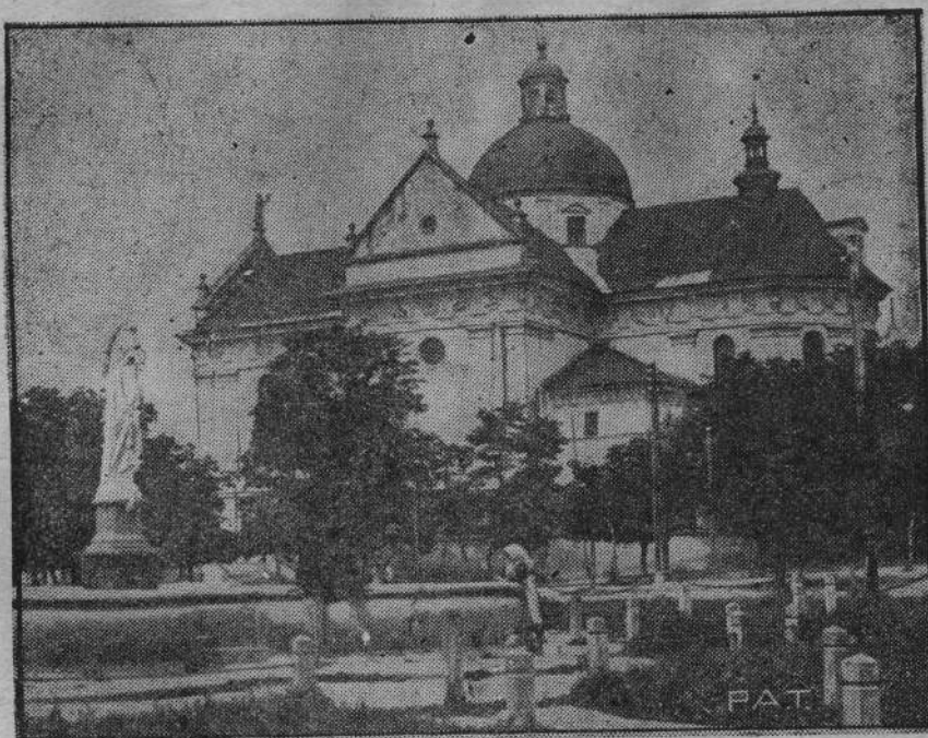
Kolegjata w Żółkwi ufundowana w r. 1620 przez Stanisława Żółkiewskiego, miejsce spoczynku wiecznego wielkiego Hetmana i jego potomków stanowi jeden z najcenniejszych zabytków historycznych w Małopolsce. W kościele tym, zbudowanym przez architektów włoskich znajduje się szereg wspaniałych nagrobków rodziny Żółkiewskich, Daniłowiczów i Sobieskich.
