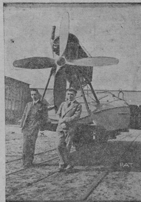
Młody berliński inżynier 28 letni Mikołaj Otto Bellin zbudował slizgowiec poruszany motorem aeroplanowym, którym zamierza odbyć podróż dookoła świata w przeciągu 150 dni. Na zdjęciu widzimy młodego konstruktora (x) ze swym przyjacielem przy aparacie. Slizgowiec odznacza się oryginalnym kształtem kropki wody i ma długość 8 metrów.
