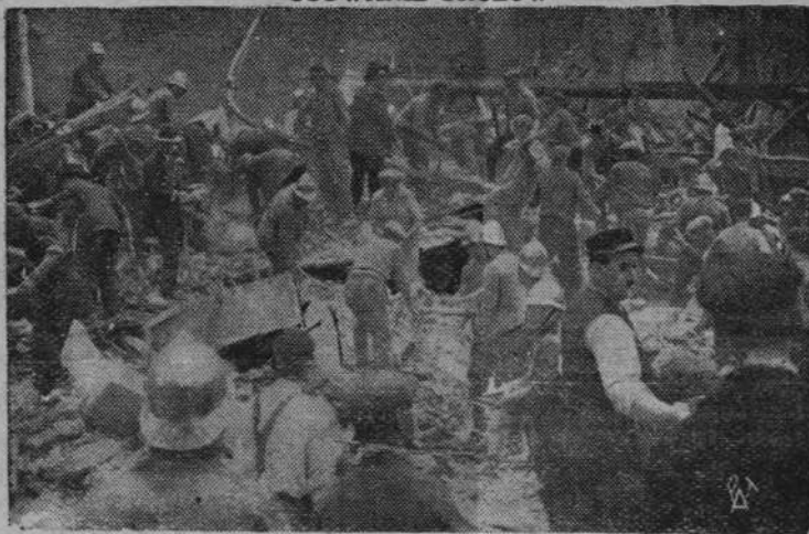
Na ilustracji naszej widzimy akcję ratowniczą przy wydobywaniu zasypanych robotników bezpośrednio po katastrofie w fabryce samochodów „Renault” w Paryżu
