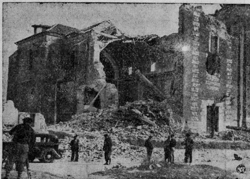
Zdjęcie nasze przedstawia widok zburzonych przez artylerię powstańczą gmachów państwowych hiszpańskich na przedmieściu Madrytu. Krwawe walki o Madryt toczą się ze zmiennym powodzeniem z niezwykłą zaciętością między armią gen. Franco, a milicją republikańską. —
