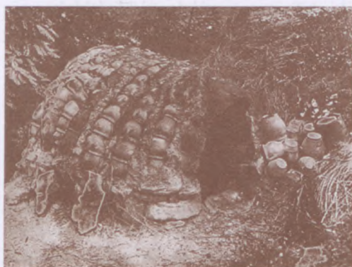
Piec garncarski typu pionowego z poziomym rusztem, kryty sklepieniem z garnków, za R Reinfussem.
