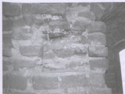
Gniazdo belki konstrukcji dzwonnicy, w trakcie prac konserwatorskich (fot. M. Oleksy).
