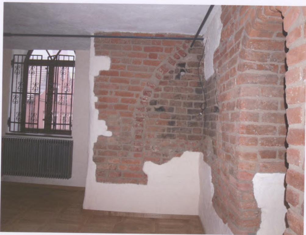
Fot. 9. Odslonięte relikty urządzenia grzewczego (fot. M. Oleksy).
