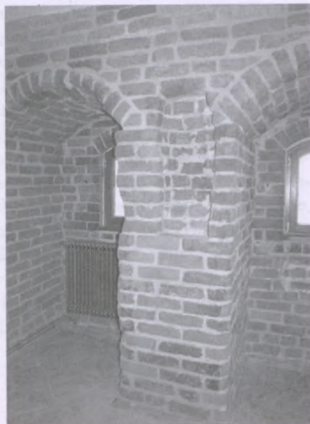
Gniazdo belki konstrukcji dzwonnicy po pracach konserwatorskich (fot. M. Oleksy).
