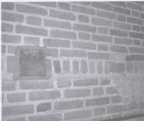
Gniazda belek stropowych i rolki wzmacniająca mur po rekonstrukcji (fot. M. Oleksy).
