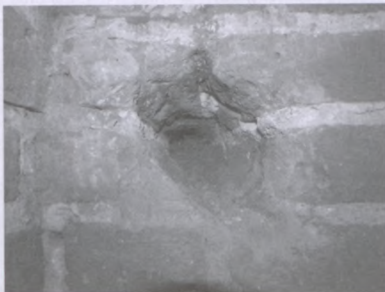
Kanał grzewczy tuż po odkryciu (fot. M. Oleksy).
