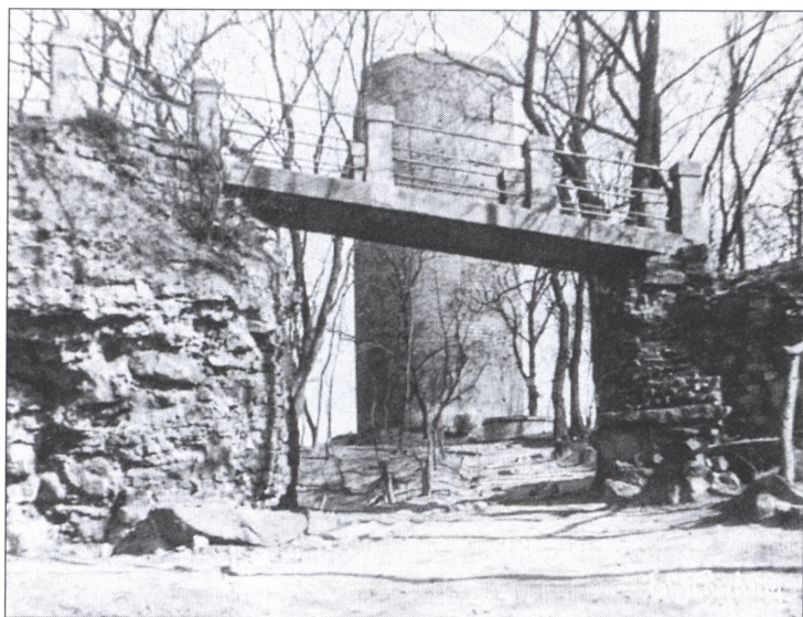
Il. 10. Ruiny zamku krzyżackiego z wieżą Klimek ok. 1931 r.
