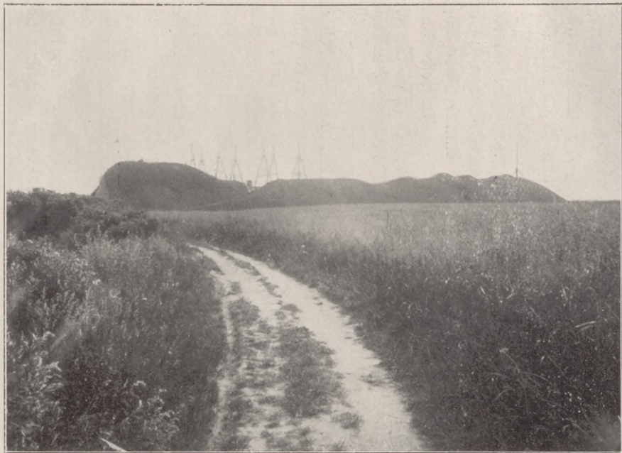
Abb. 4. Der Wall von Arfona von außen; im linken Abschnitt das Tor.
